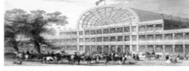
Kristal Saray 1851'de Londra'da düzenlenen I. Dünya Sergisi için inşa edildi. 564 m x 139 m x 39 m ebatında 74.000 metrekarelik sergi alanına sahiptir. Cam ve demirin ilk kez seri üretimde kullanıldığı hafif, modüler ve şeffaf mimarinin en önemli simgelerinden biri olarak kabul edilir. Endüstriyel prefabrikasyon ve montaj teknikleri kullanılarak fiyandan sonra sökülecek şekilde Henry Cole tarafından tasarlandı. 1. Görüş: https://en.wikipedia.org/wiki/The_Crystal_Palace 2. Klassen, F., Material Innovations, www.kyerson.ca/
